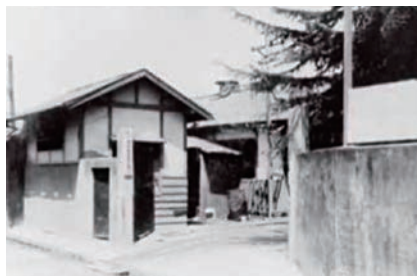
創業時の愛知県愛知郡御器所村に建設した名古屋工場
